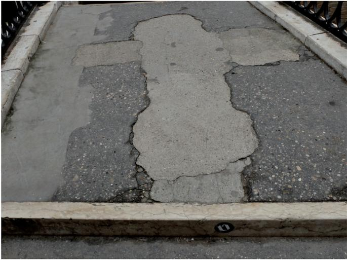
*Ponte Cavalli (S. Polo), copertura di asfalto con rappezzi di calcestruzzo*
