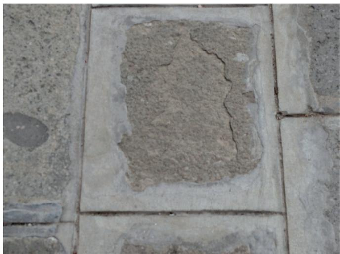
*Grave degrado a cornice di un masegno di trachite 'cementato' e 'stilato' ai bordi*
