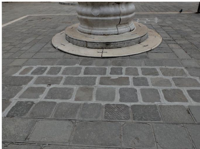
*Campo Sant'Aponal, esempio di rappezzi brutti e sbagliati con giunti cementizi: in primo piano solo ai bordi e stilati; in secondo piano anche con sormonto di colore chiaro, che molto stona con quello della trachite*
